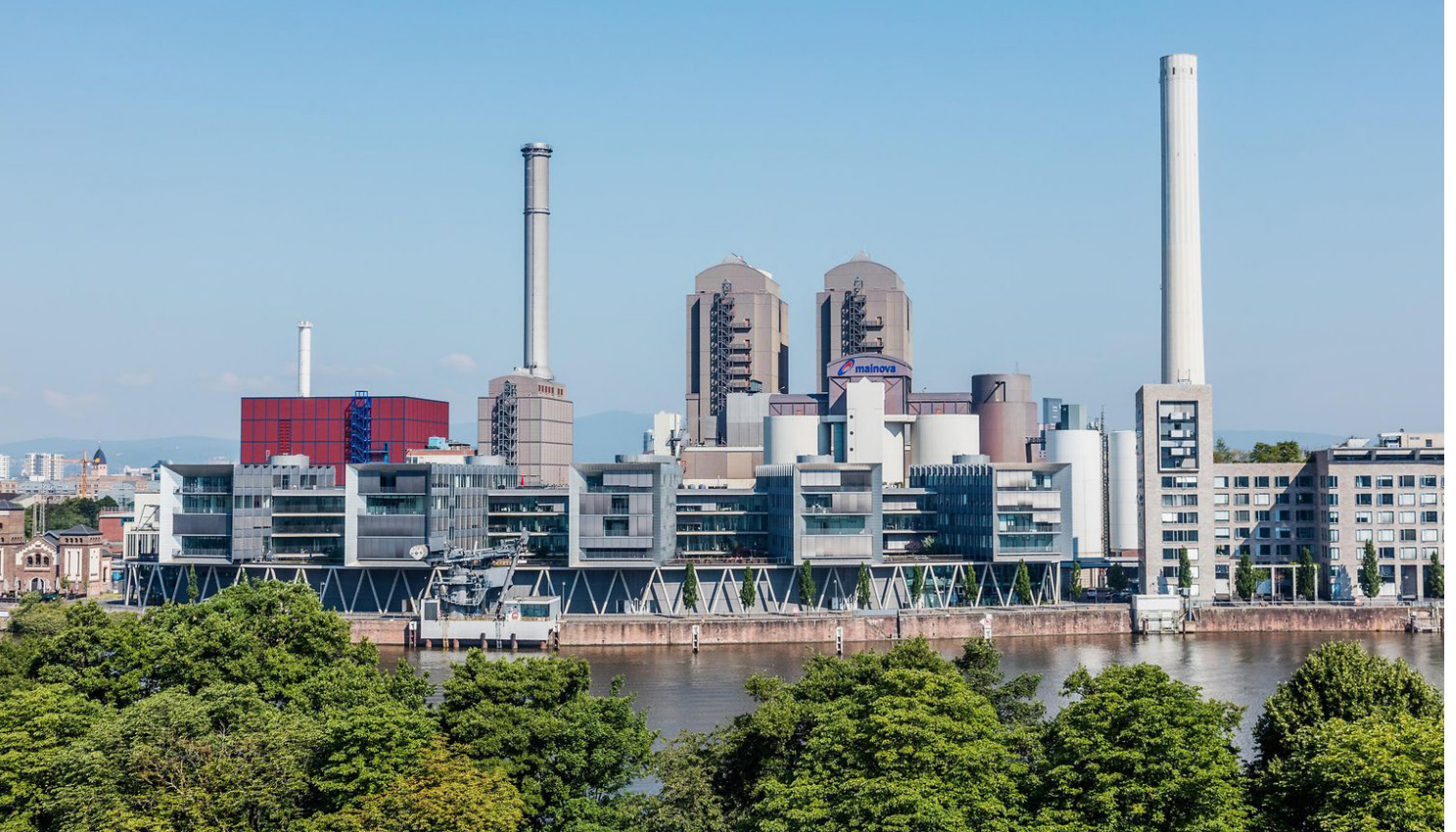
Heizkraftwerk West der Mainova AG
