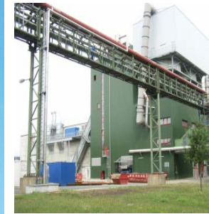
Biomasse- Kraftwerk Fechenheim » 71.000 Tonnen
