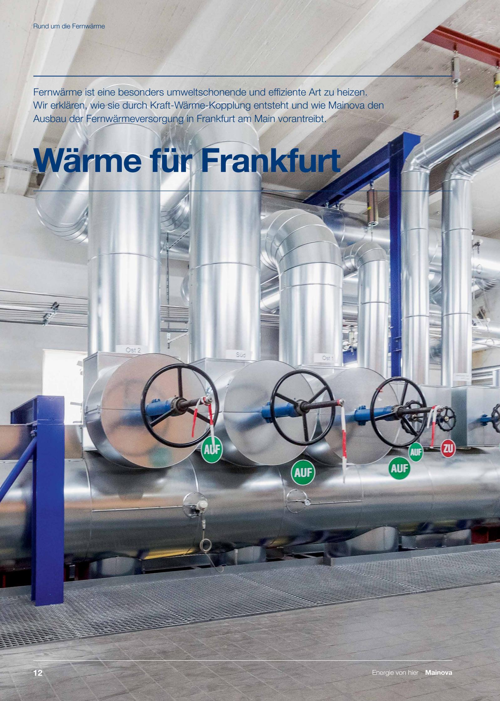
**F**ernwärme entsteht in Heizwerken oder in Heizkraftwerken unter Einsatz des besonders umweltschonenden Verfahrens der Kraft-Wärme-Kopplung. Dabei werden Wärme und Strom parallel erzeugt. Die produzierte Wärme gelangt anschließend über ein gut gedämmtes Leitungssystem zu Gebäuden in der weiteren Umgebung des Heizkraftwerks – daher der Name Fernwärme. Erfolgt die Wärmeübertragung zwischen
