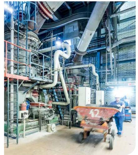
Im Bild: **zwei der Kohlemühlen** im Kesselhaus des HKW West.
