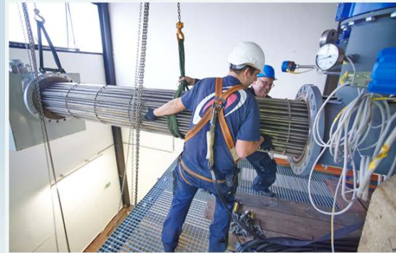
Montage der Heizstäbe in der Power-to-Heat-Anlage im Heizkraftwerk Niederrad, Frankfurt am Main.
