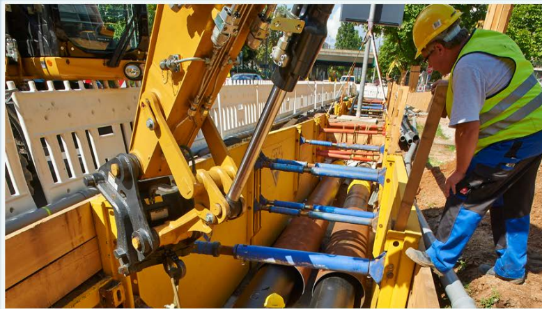
Verlegung einer Fernwärmeleitung in der Theodor-Heuss-Allee, Frankfurt am Main.
