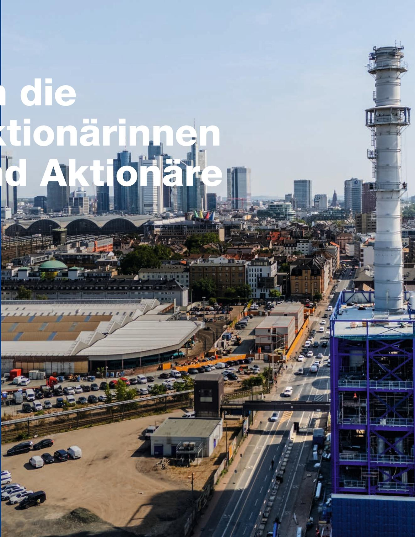
**Ausstieg aus der Kohle** – Schon im kommenden Jahr soll der Umbau am Heizkraftwerk West abgeschlossen sein. Bis dahin gibt es noch einiges zu tun, um unser größtes Kraftwerk auf den Betrieb mit Erdgas und perspektivisch mit grünen Gasen wie Wasserstoff umzustellen. Im Juli wurden die beiden Kamine (zu sehen in der rechten Bildhälfte) von einem Kran eingehoben. Sie werden künftig die gereinigten Abgase ableiten, die bei der Energieerzeugung entstehen.
