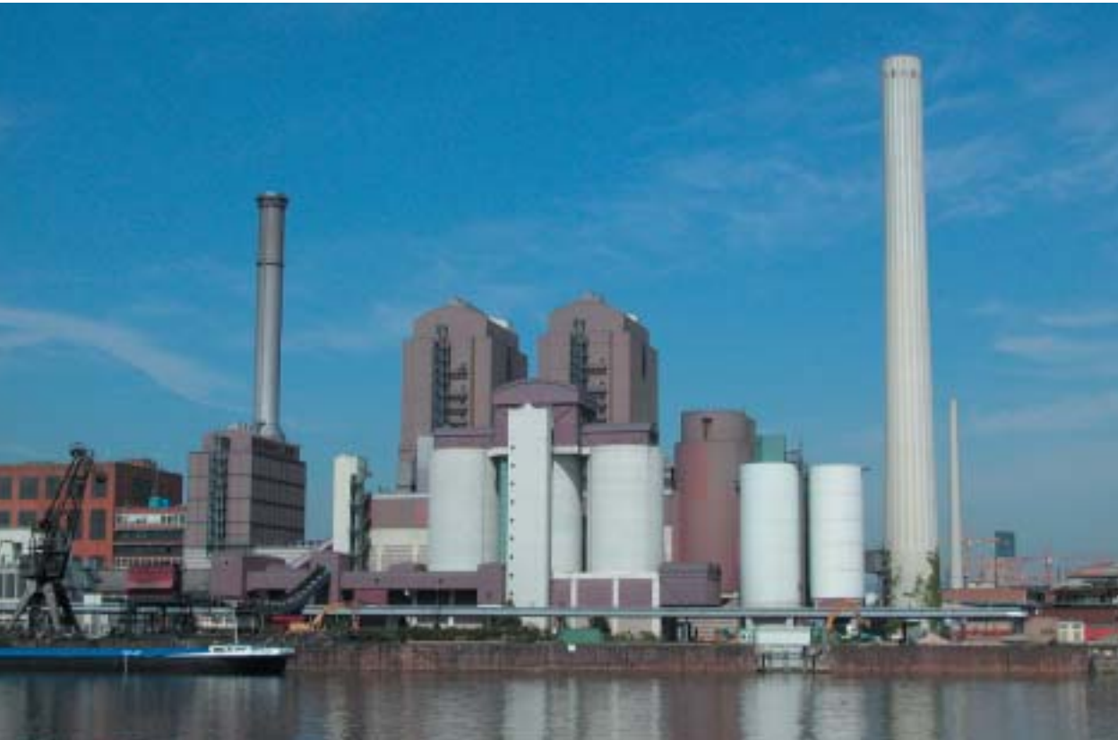
Abbildung: HKW West
