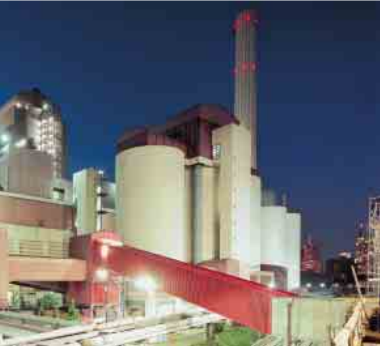
Das Heizkraftwerk West von Mainova (links) hat Anschluss an zwei der vier großen Netze von Übertragungsnetzbetreibern
